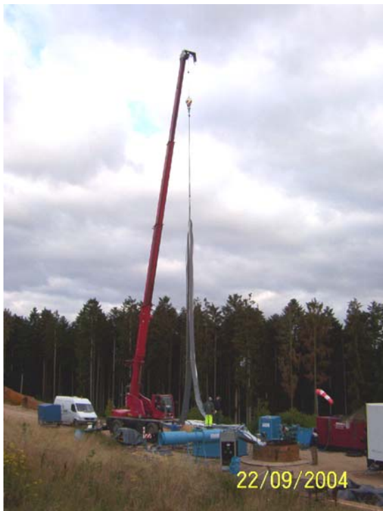
Einbau eines Inliner-Schlauchs
