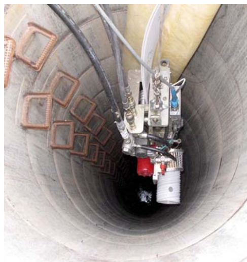
Renovierung einer Entwässerungsleitungen mit Ribloc-Wickelrohr
