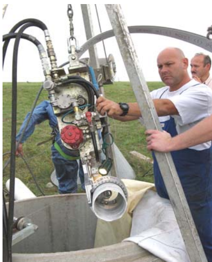
Renovierung einer Entwässerungsleitungen mit Ribloc-Wickelrohr
