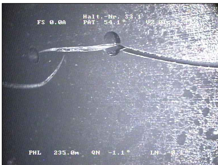
Typischer Längsriss beginnend an einem Loch
