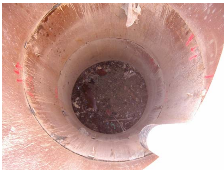
Austausch eines Rohrkurzstückes im Schutze eines Stahlrohverbandes
