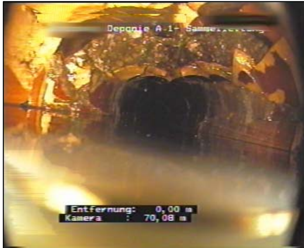
Offener Rohrscheitel bei 70 m
